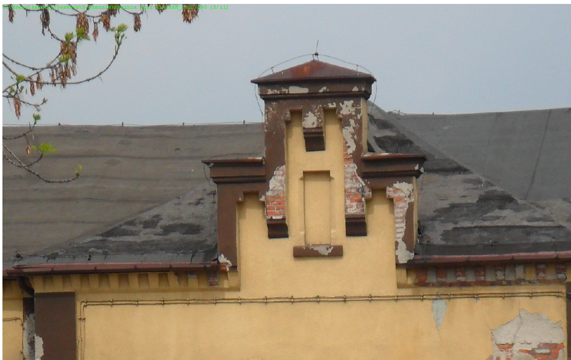
Fot. 4. Zachowany detal architektoniczny – schodkowy szczyt pawilonu ubojni – po otynkowaniu i niewłaściwych remontach, stan obecny.
