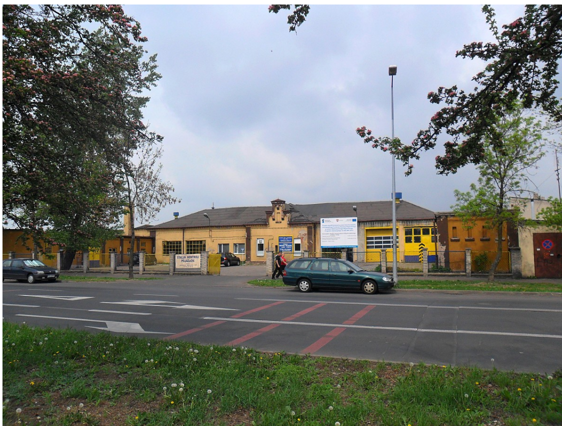
Fot. 3. Stan obecny dawnego budynku rzeźni kaliskiej, widok od ul. Złotej. W centrum przeddziedzińca znajdował się niegdyś parterowy budynek administracyjny.
